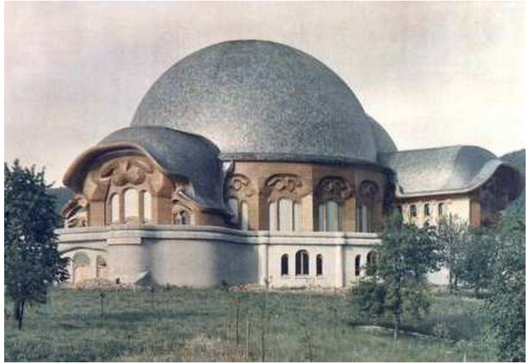
(Erstes Goetheanum, in der Silvesternacht 1922/23 durch Brandstiftung zerstört.)
