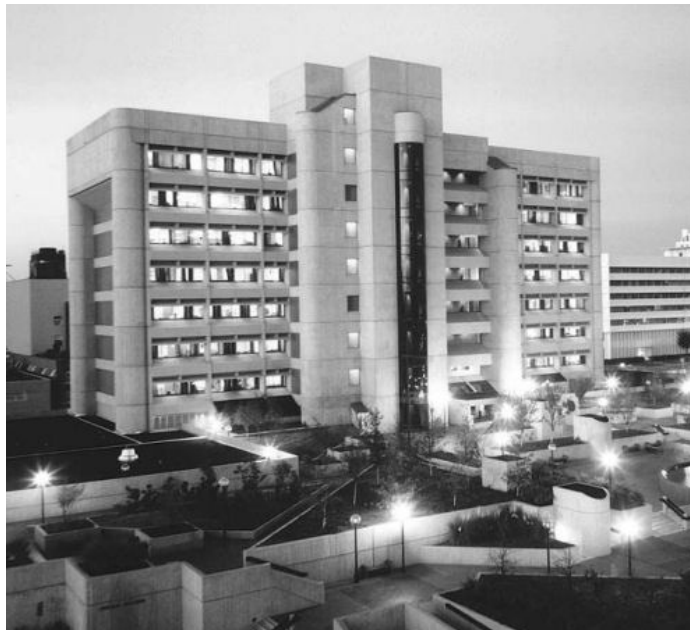
(Die Rückseite des Murrah Federal Building mit Aufzugsschacht)
