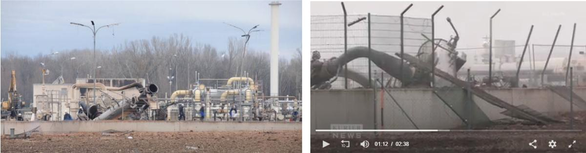
(Das linke Bild ist das obere Bild aus Artikel 2565, S. 3. Es ist eine Teleobjektivaufnahme, deswegen erscheint das Rohrsystem wie "zusammengedrängt". Die gelben Rohre sind von der Explosionsstelle weiter entfernt [s.u.]. Das rechte Bild ist das untere Bild aus Artikel 2565, S. 3.)
