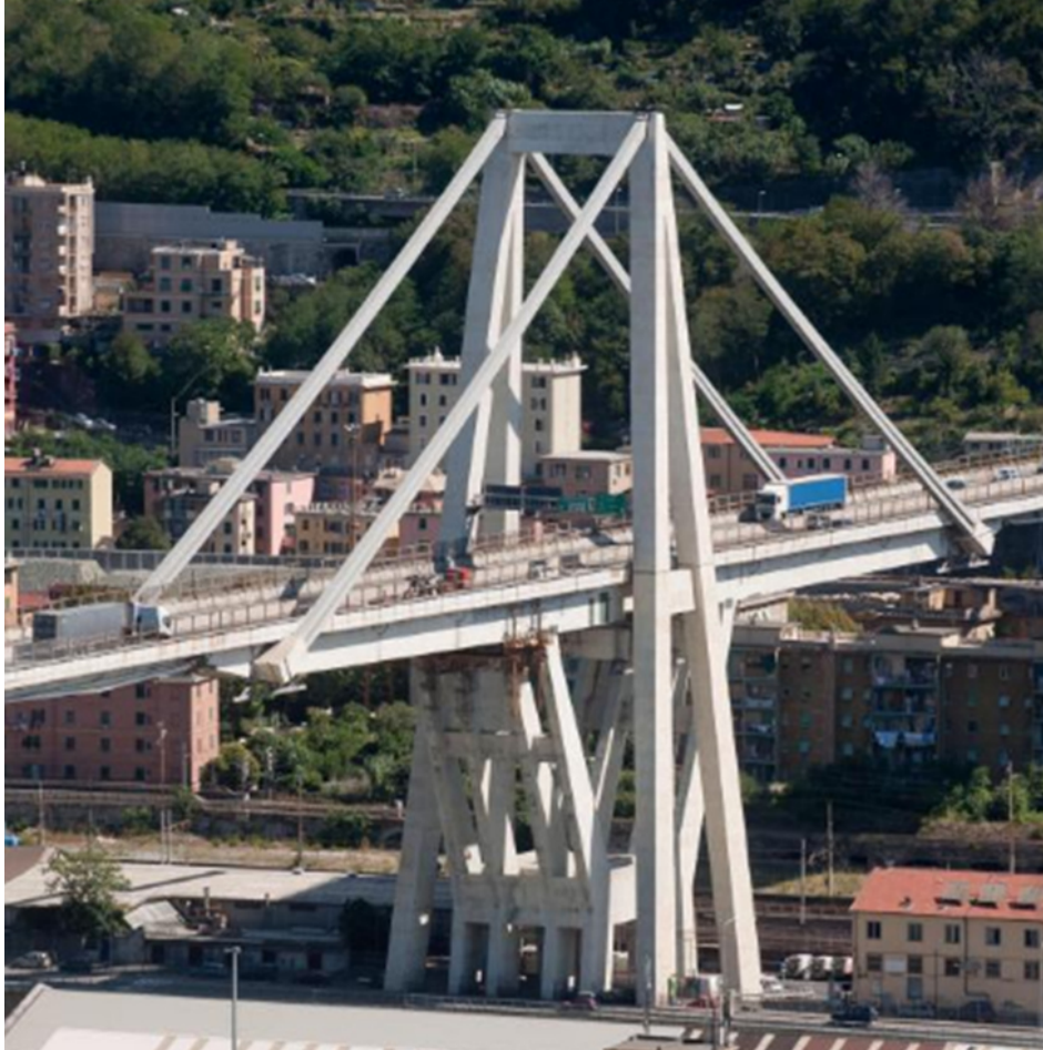
(Der gestern vollständig eingestürzter Pylon mit Brückenabschnitt 10 )
