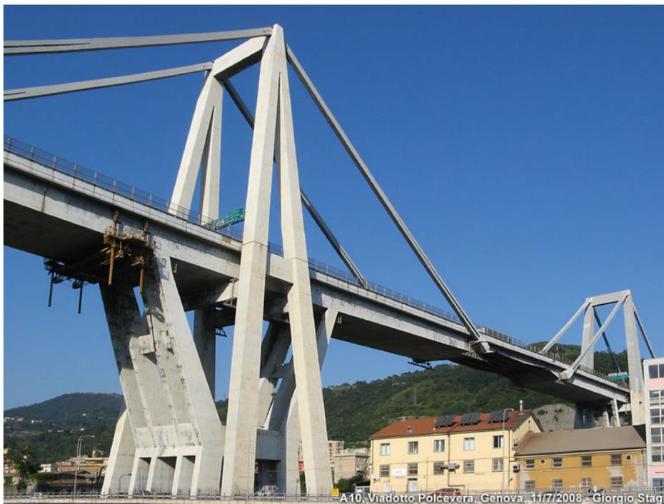
(Der 2018 eingestürzte Pylon mit den einbetonierten<sup>4</sup> Stahlseilen (2008)<sup>5</sup>)
