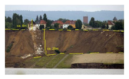
Die horizontalen gelben Striche zeigen den Kraterrand an, die vertikalen die Tiefe bzw. die Höhe des Hauses. Es sind also <u>nicht</u> ...mehr als 100 Meter Tiefe, sondern gerade mal <u>ca. 20</u> Meter<sup>3</sup>.
