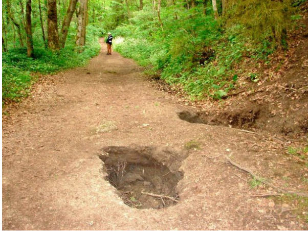
(Geländebruch in Baden)
