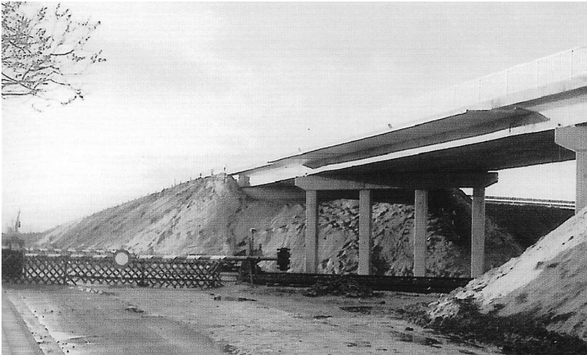
Die (Rebberlaher-Strassen-)Betonbrücke vor der Katastrophe – ein Bauwerk einfachster Art mit auf zwei Trägern aufgelegter Betonplatte ...<sup>39</sup>
